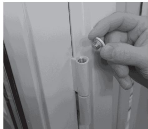
Fig 37. Slik fjerner du dekklokket på toppen av hengslene.
