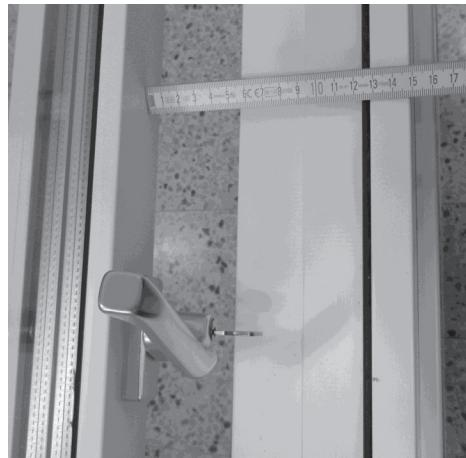
Fig 24. Åpningssperren skal stoppe vindusrammen slik at åpningen ikke overstiger 10 cm.
