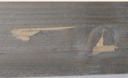
Träspackel på dypimpregnerat trä
