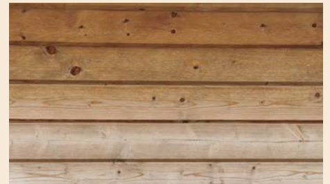
Väggen på en trädgårdsstuga som impregnerats brun och som har stått utomhus i fyra år utan ytterligare efterbehandling. Den del som utsatts för solen är kraftigt blekt.
