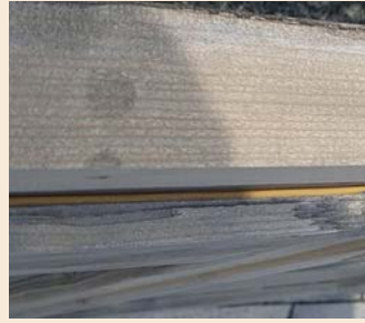
Impregneringsvätska når inte alla ytor
