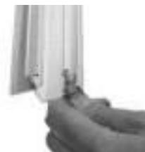
Schrauben Sie die Profile zusammen, indem Sie die Vierkantschrauben in den Profilkanal schieben und am Loch im entsprechenden Balken befestigen. Ziehen Sie die Muttern erst dann fest, wenn der Rahmen vollkommen rechtwinklig ist. **ALLE ANSCHLUSSPROFILE MÜSSEN BÜNDIG UND FEST VERBUNDEN SEIN, UM UNDICHTIGKEITEN AUF EIN MINIMUM ZU REDUZIEREN.**
