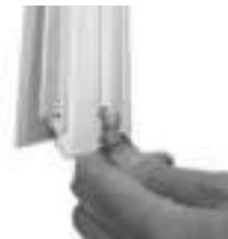
Fäst profilerna samman genom att föra de fyrkantiga bultarna in i profilens kanal och fäst dem i hålet i den motsvarande skenan. Spänna inte åt muttrarna helt innan hela ramen är i rätt ställning. **OBS: ALLA PROFILER SOM KOPPLAS BÖR FÄSTAS JÄMNT OCH SPÄNT FÖR ATT MINSKA RISKEN FÖR LÄCKAGE.**
