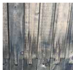
Synlige tørkemerker etter trykkimpregnering
