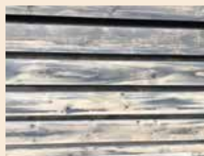
Synlige tørkemerker etter trykkimpregnering
