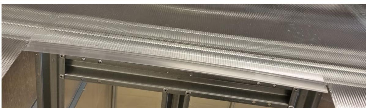
**5.** Kiinnitä pitkä tuki kulmaraudan ja vastamutterien avulla. Poraa reikä kattoikkunan profiilikehykseen ja ripusta kulmarauta tuen kanssa. Tee merkintä kasvihuoneen katon profiiliin kohtaan, johon poraat, ja aseta sitten pitkä ruuvi siihen, jotta se työntyy ulos ja voi kiinnittyä riippuvaan tukeen. Voit lukita riippuvan tuen pitkään ruuviin mutterilla ja estää sen, että kattoikkuna avautuu tuulen vaikutuksesta.
