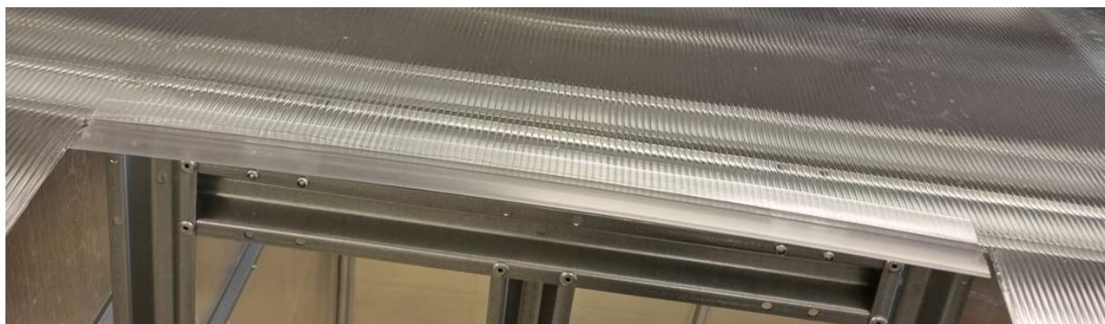
**5.** Montera ihop det långa staget med vinkeljärnet med kontramuttrar. Borra hål i takfönstrets profilram och fäst vinkeljärnet med staget hängandes. Gör en markering i växthustakets profil var du ska borra och sätt sen den långa skruven där så den sticker ut och kan haka i det hängandet staget. Använd en mutter längst ut på den långa skruven för att låsa det hängande staget och för att förhindra att takfönstret blåser upp.
