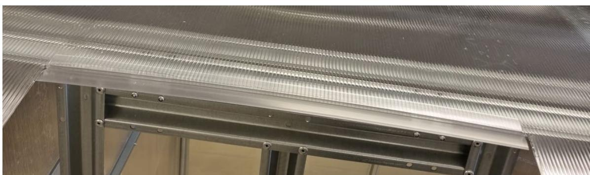
**5.** Monter det lange staget sammen med vinkeljernet med kontramutre. Bor hull i takvinduets profilramme og fest vinkeljernet med staget hengende. Lag et merke i drivhustakets profil er du skal bore og sett deretter den lange skruen der, slik at den stikker ut og kan hektes i det hengende staget. Bruk en mutter ytterst på den lange skruen for å låse det hengende staget og for å hindre at takvinduet blåser opp.
