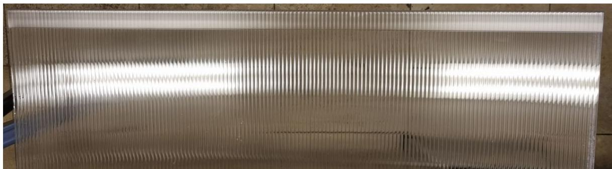
**4.** H-formad plastlist monterad längst upp i den uppskurna öppningen på växthusets kanalplasttak.
