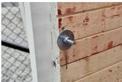
Brickor som distans mellan låsklyka och vägg.
