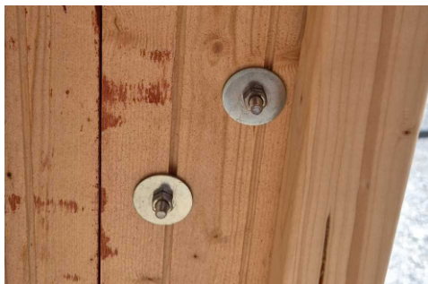
Infästning av låsbom insida dörr
