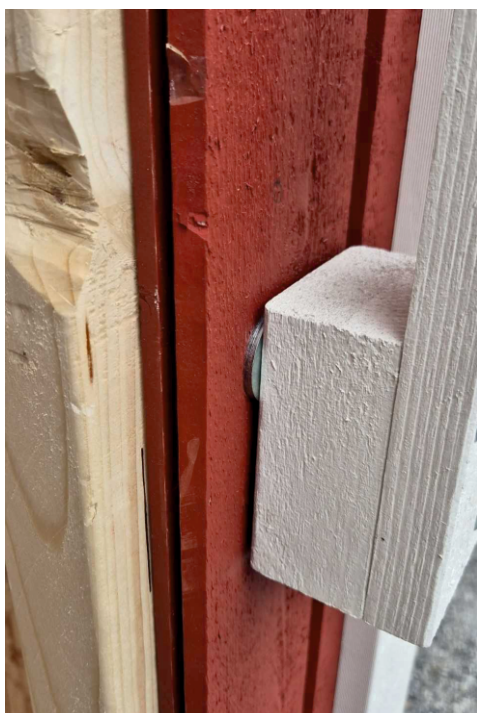
Brickor som distans mellan låsklyka och vägg.
